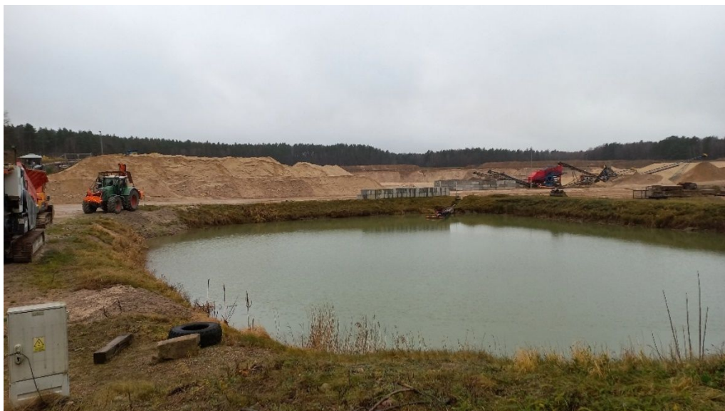
Fot. 2. Jeden z antropogenicznych zbiorników wodnych znajdujących się w północno-wschodniej części obszaru objętego projektem planu.
