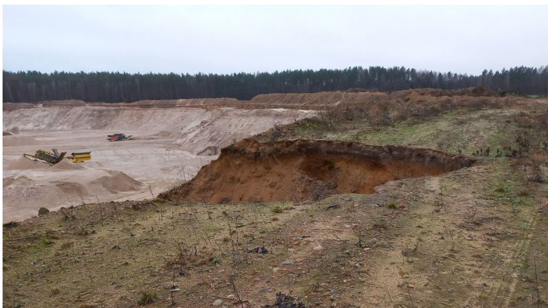
Fot. 5. Widoczny obryw w ciągłości skarpy brzeżnej wyrobiska.
