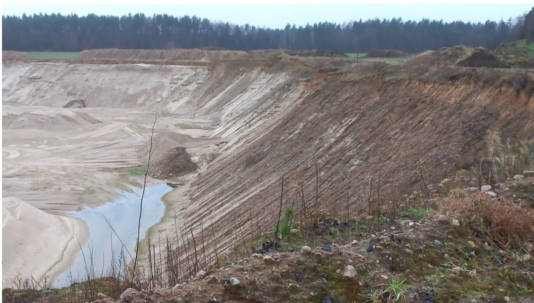
Fot. 6. Strome skarpy wyrobiska w kopalni „Topaz” bez widocznych obrywów.
